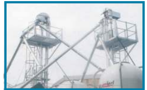
Silobefüllung mit Becherelevator
