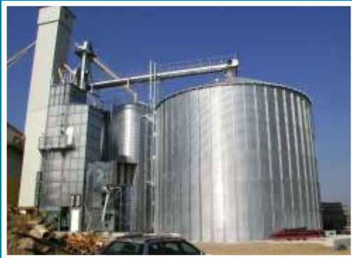
Schnelle und kostengünstige Montage der Anlage. Aus der CAD-Vorlage entsteht eine komplette Siloanlage.
