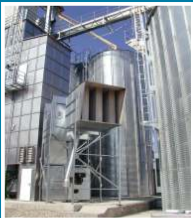
Silo mit Trocknungsanlage
