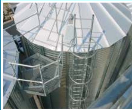
Aufstiegsleiter, Zwickelpodest, Dachleiter für Rundsilo
