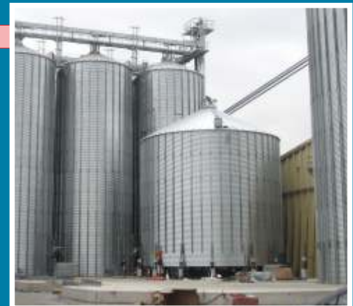
Silomontage mit Hebewinden
